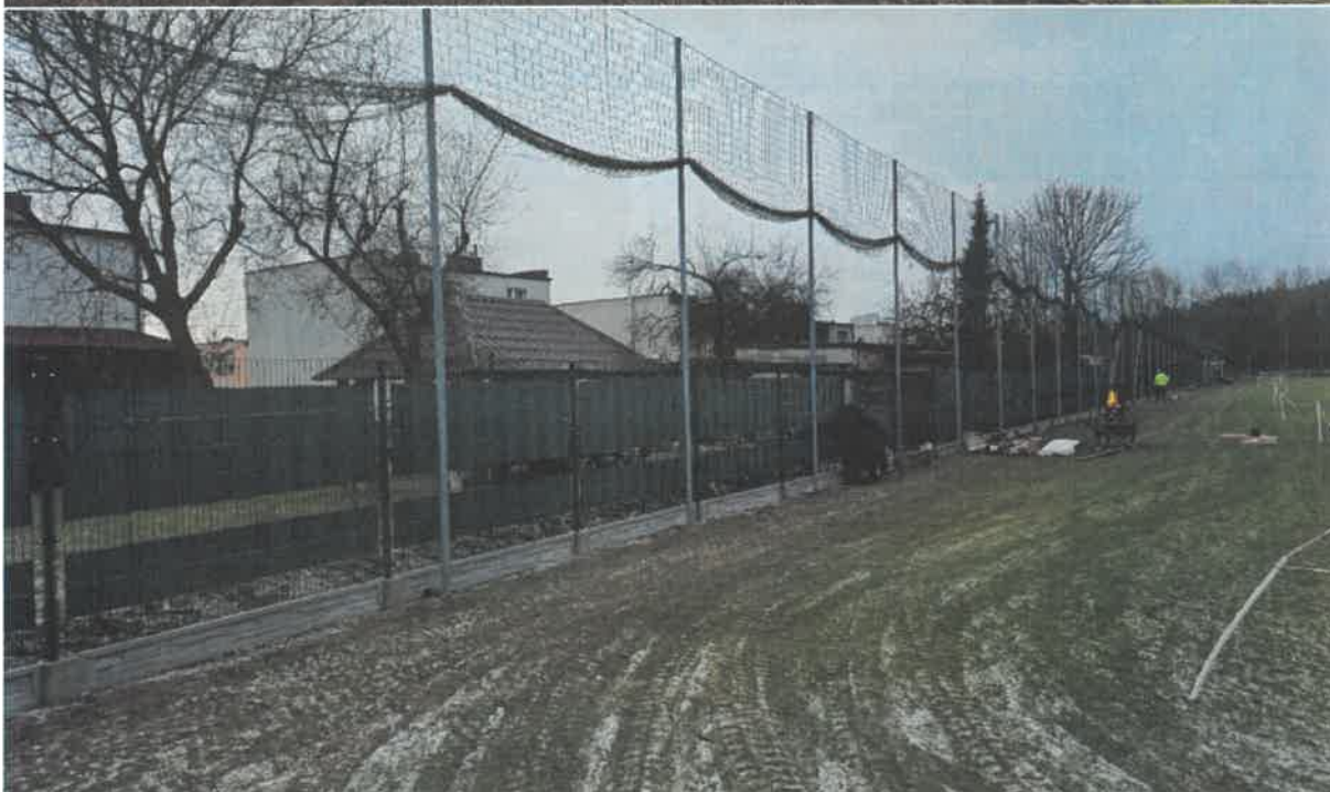
Modernizacja ogrodzenia na Stadionie Miejskim w Miastku (PO)
