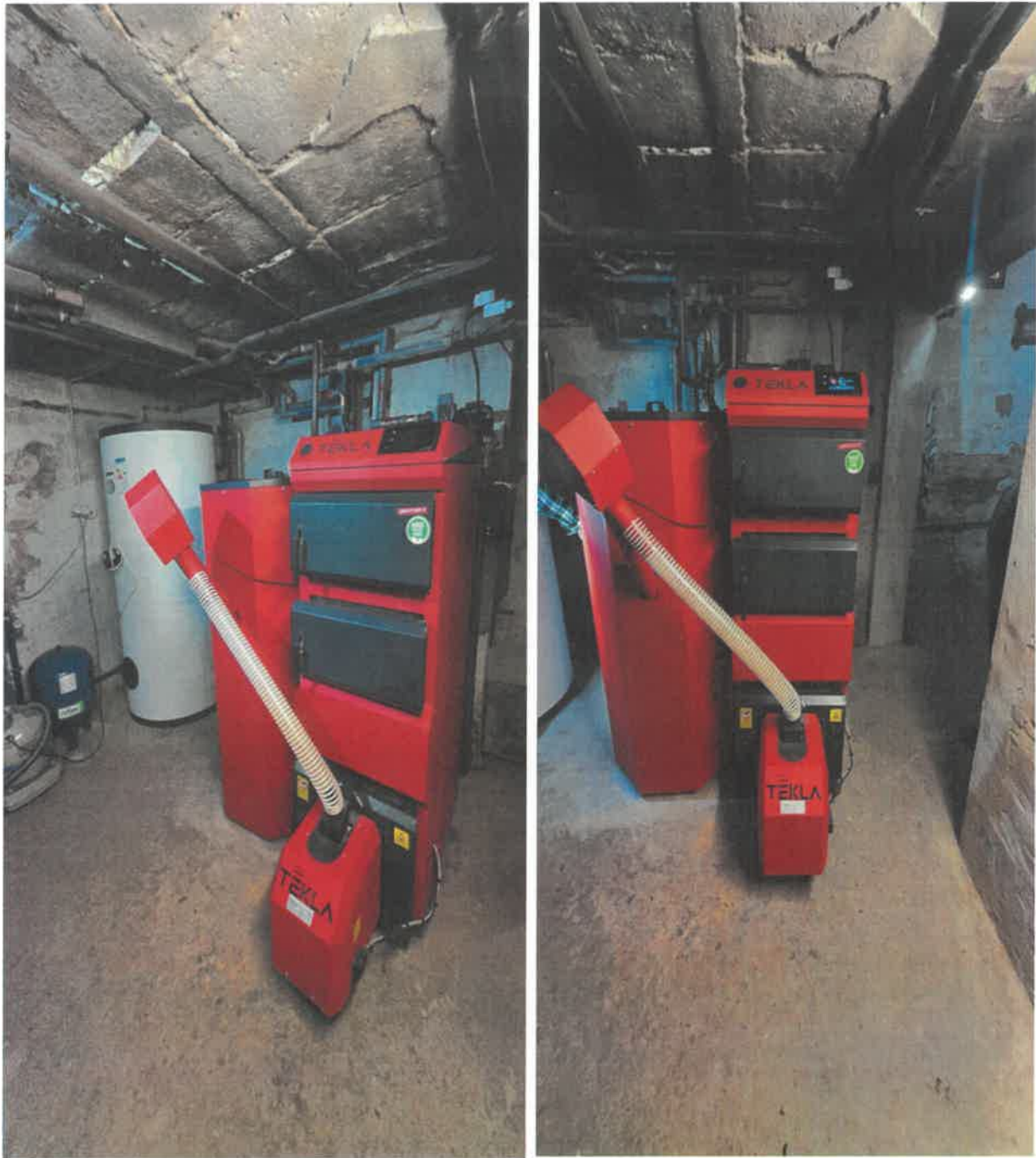
Wymiana kotła centralnego ogrzewania w budynku szatniowym na Stadionie Miejskim
