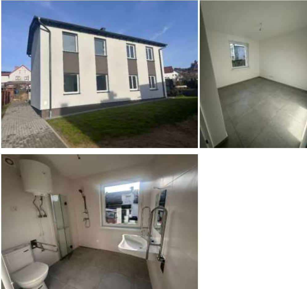
Fotografia 4. Przebudowany budynek mieszkalny przy ul. Łąkowej 4a
