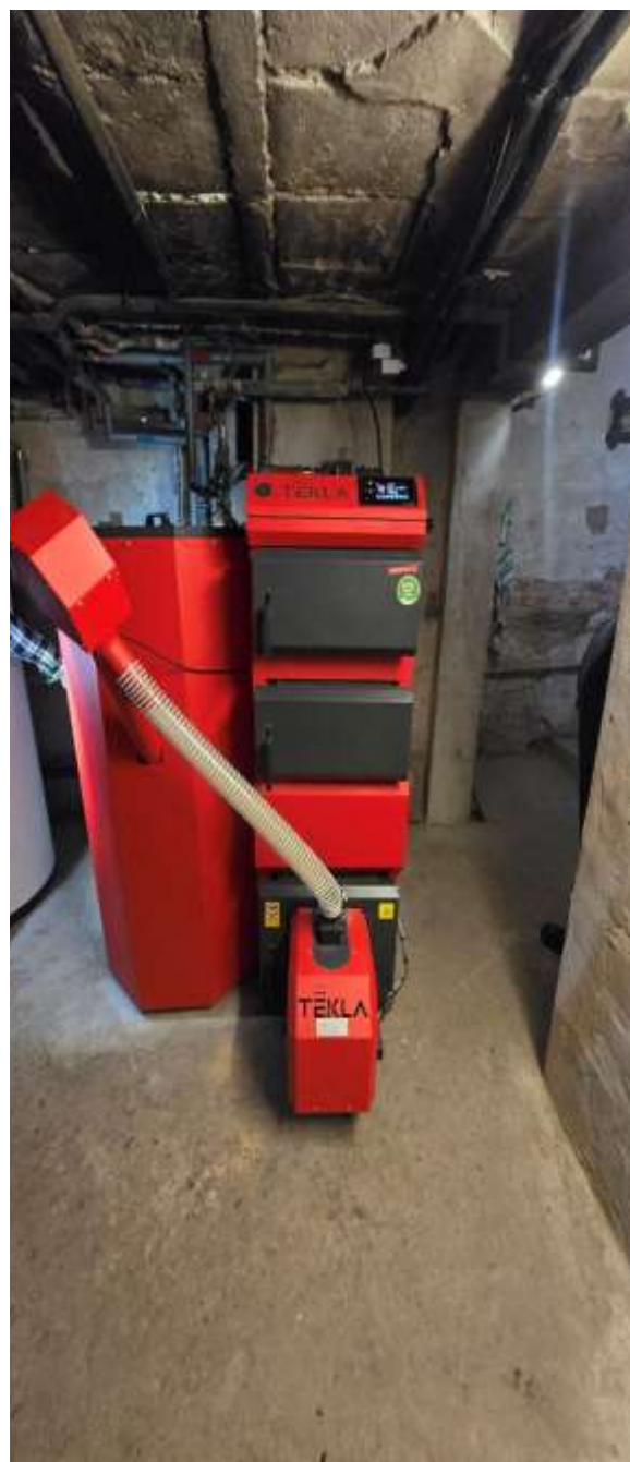
Wymiana kotła centralnego ogrzewania w budynku szatniowym na Stadionie Miejskim
