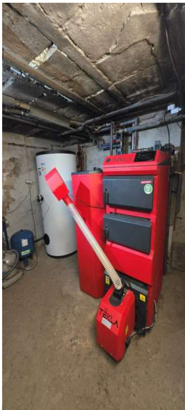
Wymiana kotła centralnego ogrzewania w budynku szatniowym na Stadionie Miejskim
